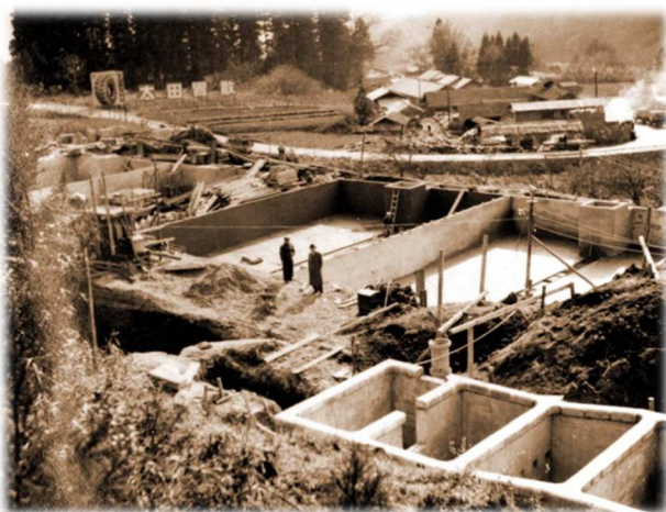
建設中の坂本浄水場
