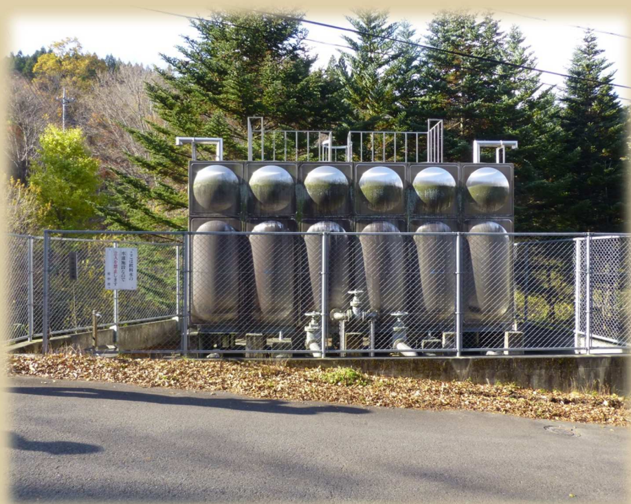
入牧第一圧力調整池
