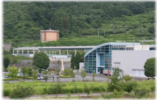
北陸新幹線安中榛名駅と間野田配水池
