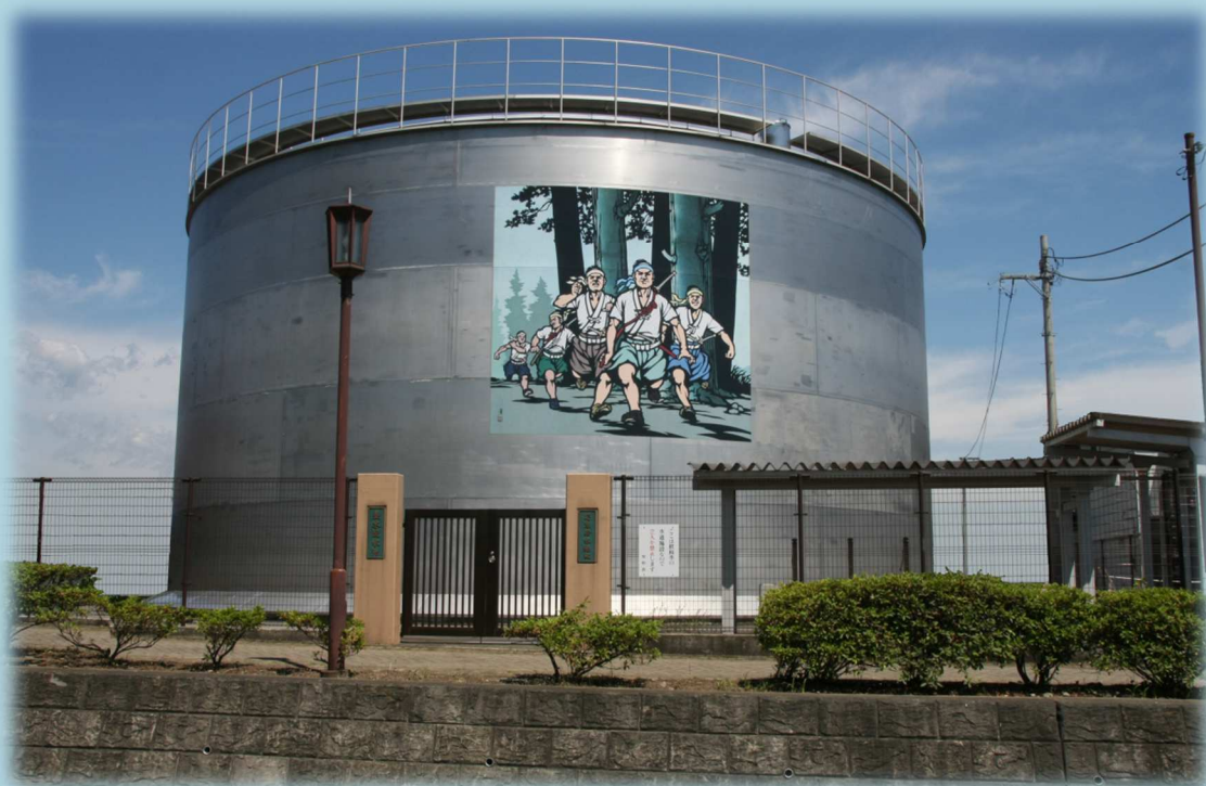
並木副配水池
