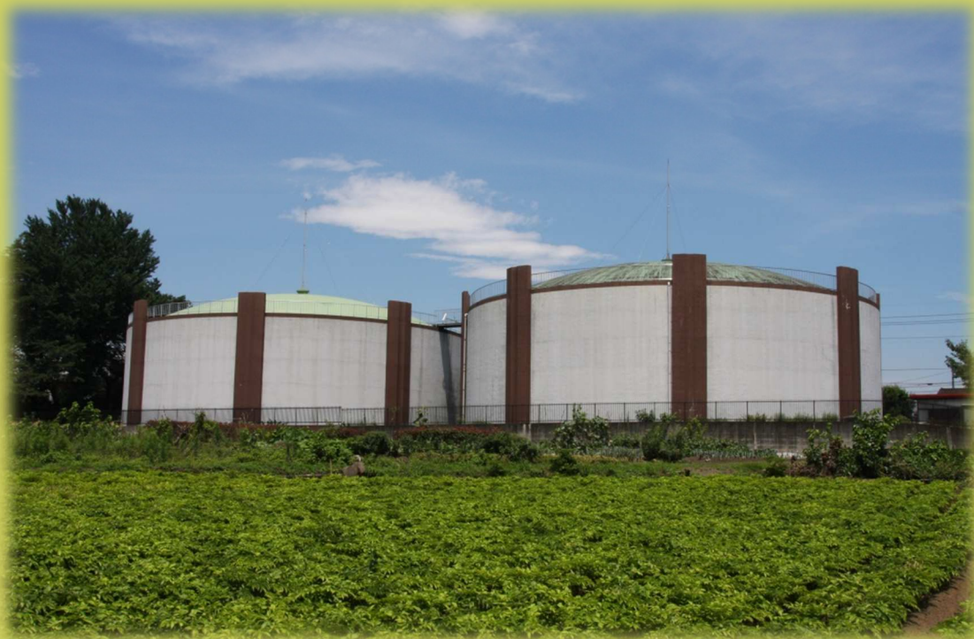
西郷原配水池
