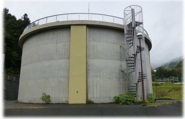
滝ノ入配水池
