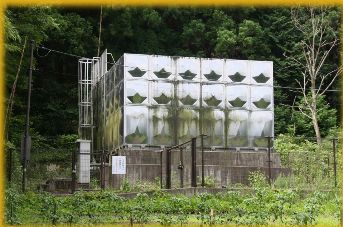
栃久保配水池
