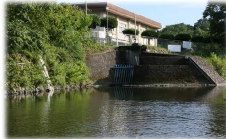
久保井戸浄水場取水施設(人見堰)
