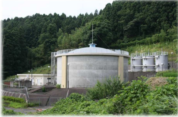
滝ノ入浄水場
