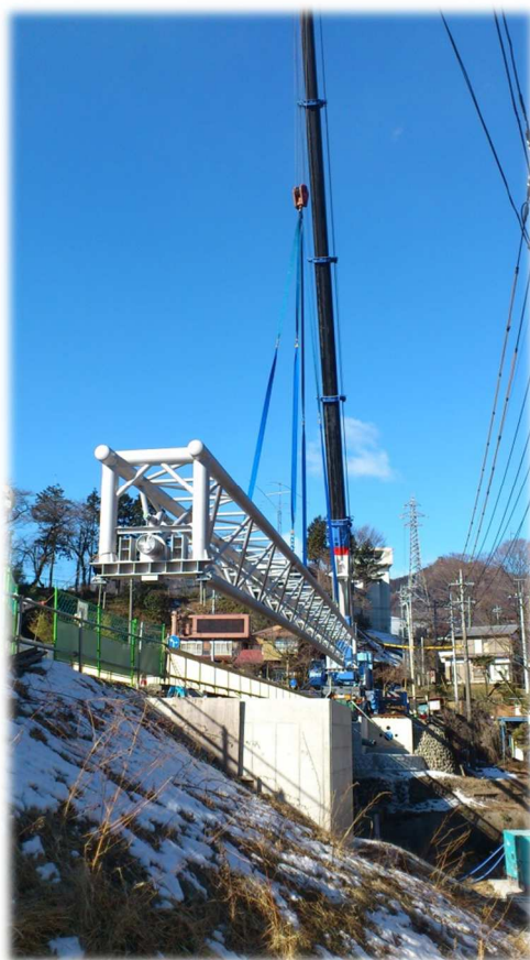
霧積川の水管橋架設状況
