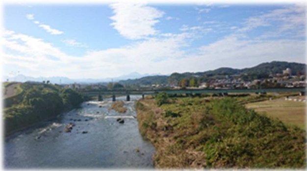
碓東大橋より安中市街を望む
