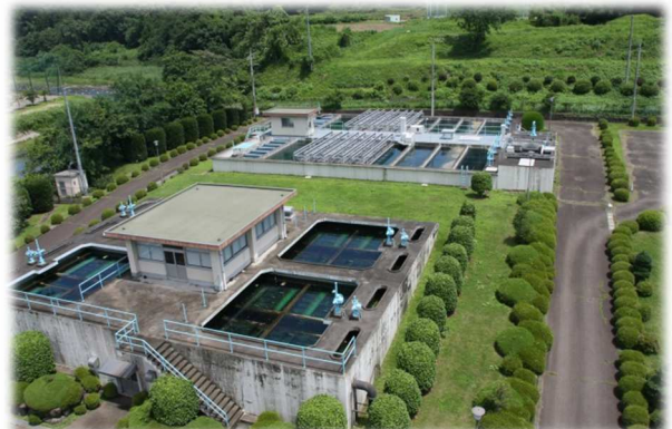
急速ろ過池(手前)と沈殿池(奥)
