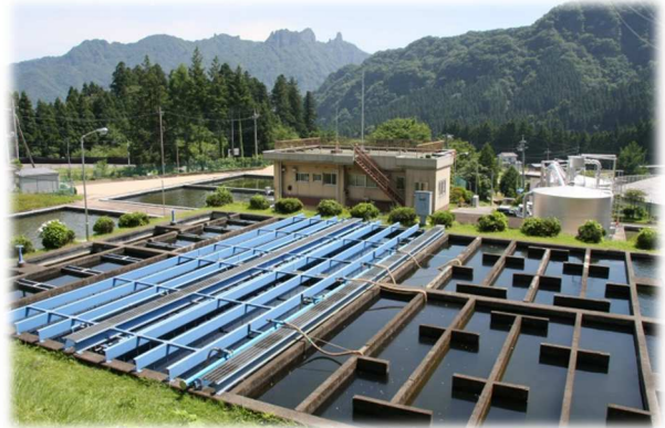
フロック形成池と沈殿池
