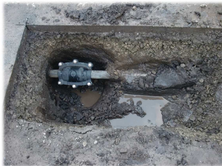
ビニル管 φ50mm の配水管漏水修理
