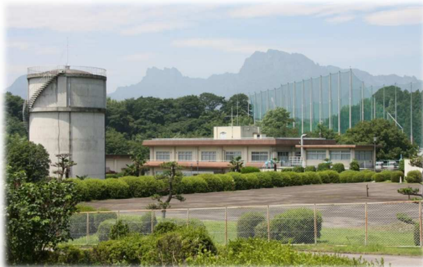
管理棟(右)と高架水槽(左)
