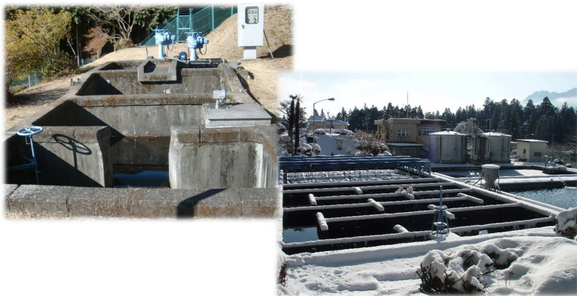
坂本浄水場第一水源(碓氷川)系着水井(左)と沈殿池(右)
