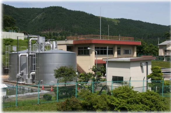
管理棟(右)と急速ろ過機(左)
