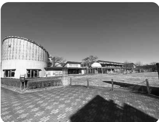
市内の廃校舎 (旧九十九小学校)
