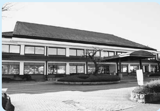
安中市役所松井田庁舎
