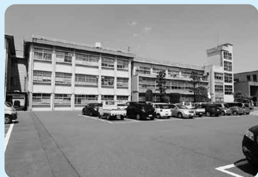
老朽化した旧庁舎・中庁舎
