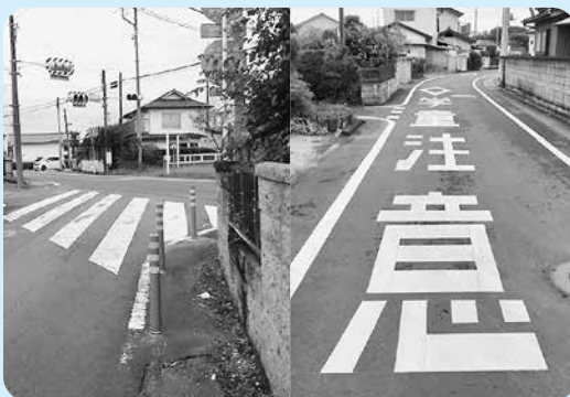
危険箇所に設置されたコーンポストと路面標示
