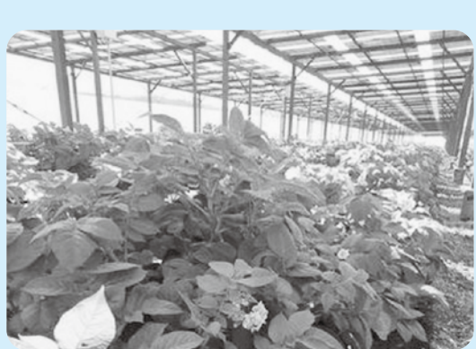
営農型太陽光発電施設の様子
