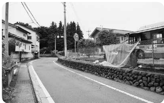
危険な通学路である 市消費生活センター南側市道
