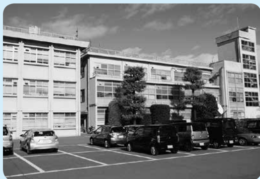
老朽化が進む市庁舎
