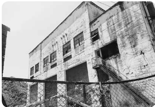
整備が待たれる熊ノ平変電所
