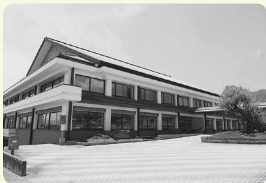
平成3年建築の松井田庁舎
