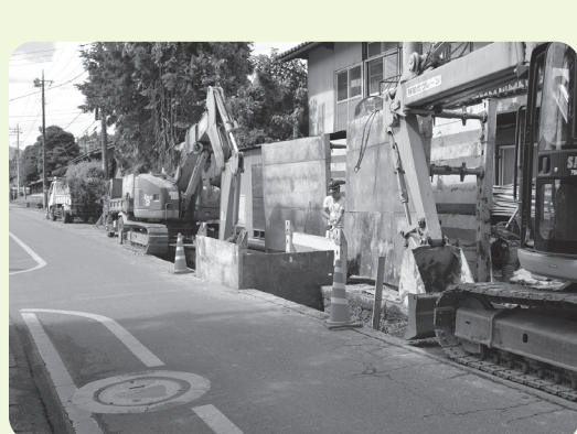
下水道工事風景
