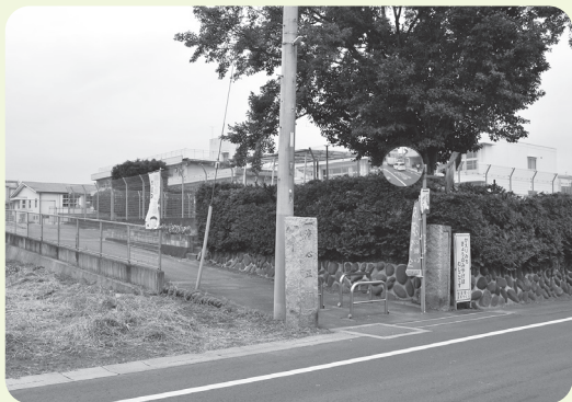
原市小学校東門の排水路
