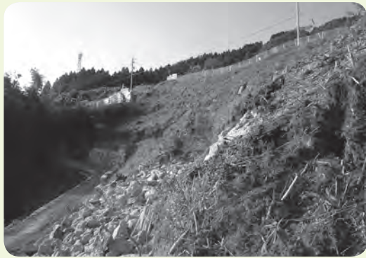
発電施設が予定されている傾斜地
