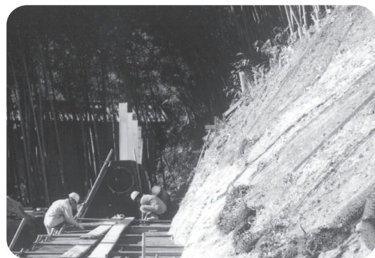
急傾斜地崩壊防止工事
