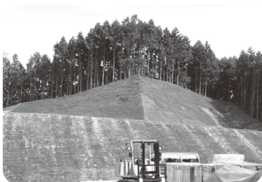
名山地区太陽光発電設置予定地
