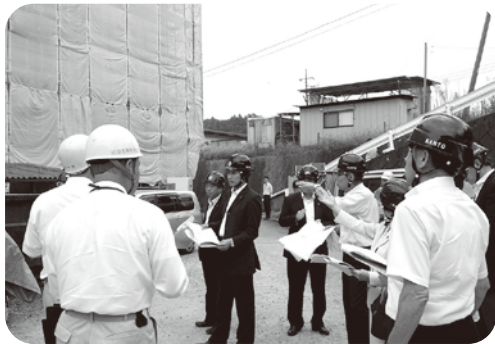
市営住宅秋間団地改修工事
