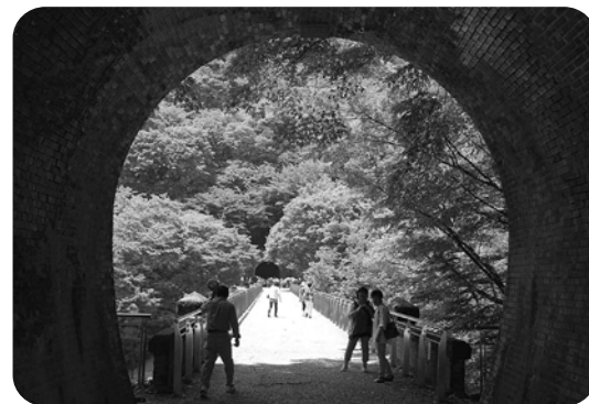
アプトの道 (碓氷第三橋梁)
