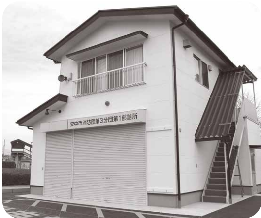
新築された消防団詰所
