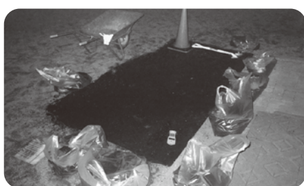
汚染土の処分状況
