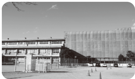
工事中の安中第二中学校
