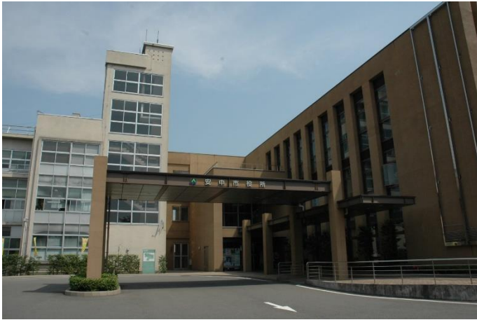
【安中市役所本庁・新庁舎】
