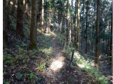
ロープ柵 木製の杭や、プラスチック杭(黒色)にてトラロープでつくられている。
