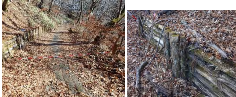
熊野神社を越えて、 思婦石がある手前 の土留工
