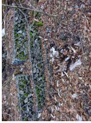
写真①↑ 道路を横断する 沢の上流端部に ふとんがごを設 置し、土砂や水 を制御している。 (和宮道)
