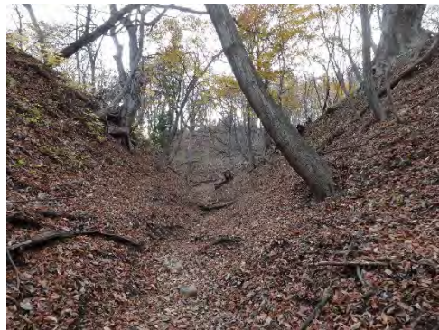
座頭転がし 道の侵食のほか、法面の侵食も進行している。
