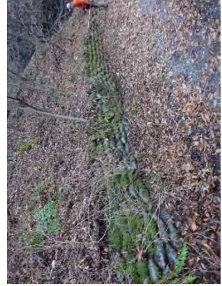
写真② 土嚢を使用した土留め(和宮道)
