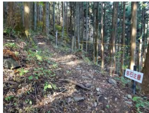
樹木にまいたロープ柵(既存補修は1-A-4参照) 大径木の樹木に、ロープを固定して、抑止柵としている。
