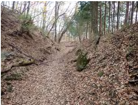
栗ヶ原付近(西側)のV字谷の地形となった道 の侵食のほか、法面の侵食も進行している。
