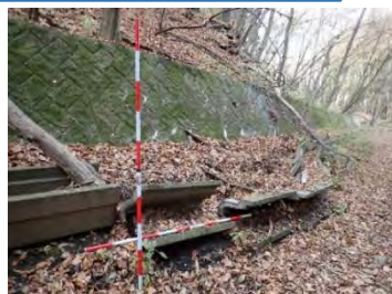
側溝の撤去（道筋とも関連する）
