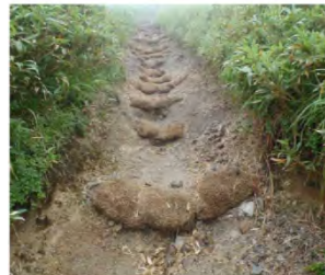
水路化区間の床止工 段差が生じている
