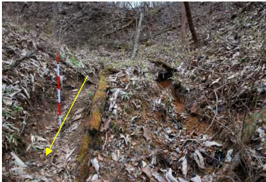
道が侵食されているが、さらに、側方にも水道が作られている。
