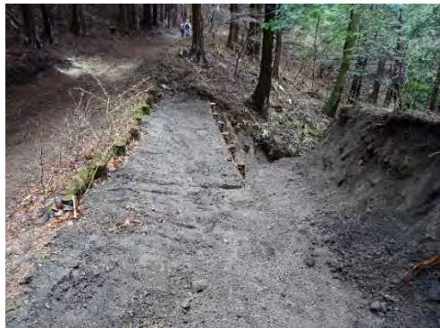
子持山付近の土留め(2019/4/25撮影)
