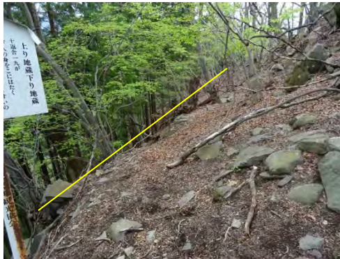
上り地蔵、下り地蔵に向かう道には、安全確保のため、注意喚起柵を設置する。
