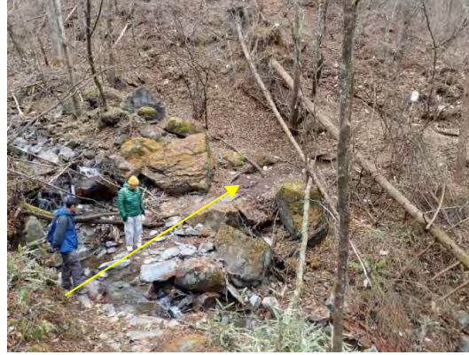
笹沢の現況 (2019.11.26撮影)
