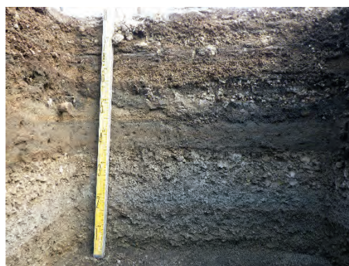
写真 4.14 No. 5 西側トレンチ東端土層
