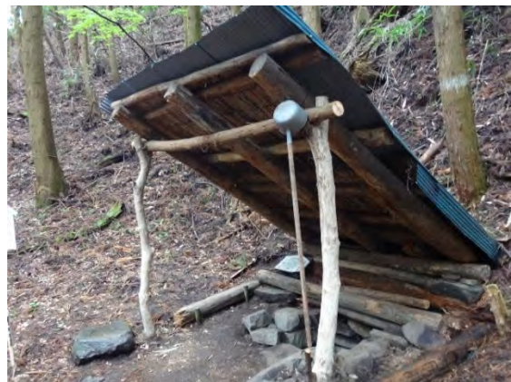
写真 4.28 弘法の井戸 現況写真
