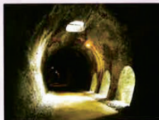
排煙口のある6号トンネル内部
