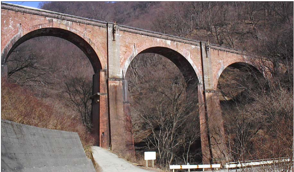
写真:13 碓氷第三橋梁(めがね橋)
