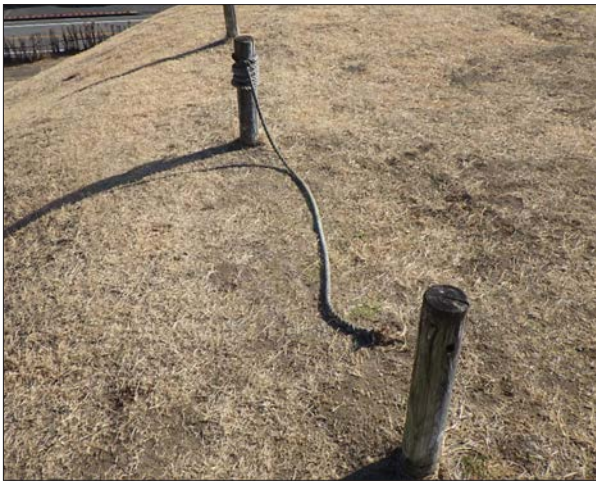
写真：41 木柵ロープの切れ（第31図-③）
