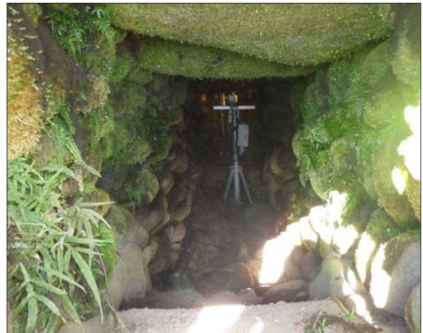
写真：46 開口部から見た石室内（第31図-⑧）
