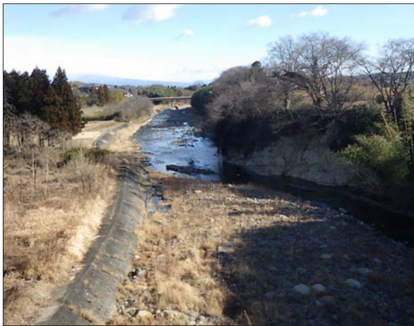
写真：54 碓氷川（東方向へ向けて撮影）
