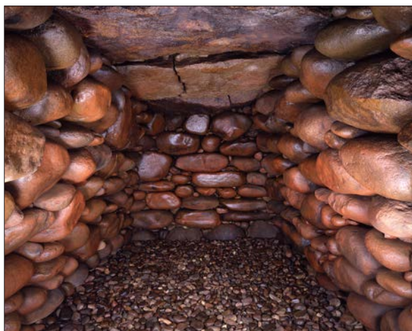
写真：47 石室玄室内の状況：計測機器設置前 （第31図-⑨）
