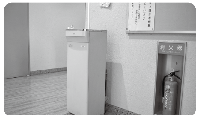
スポーツセンター内の冷水機
