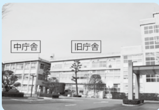
倒壊・崩壊の危険性の高い旧・中庁舎
