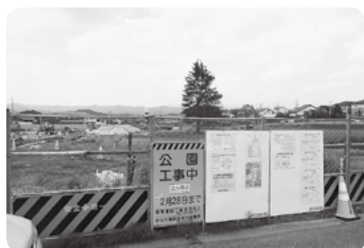
工事を中断している建設現場
