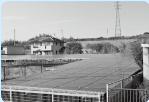
住宅周辺の太陽光発電施設
