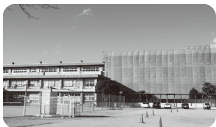
工事中の安中第二中学校
