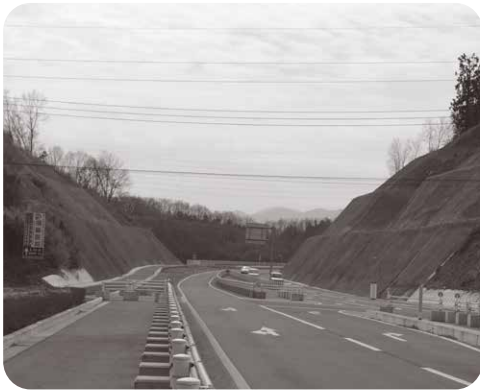
西毛広域幹線道路(富岡市内)
