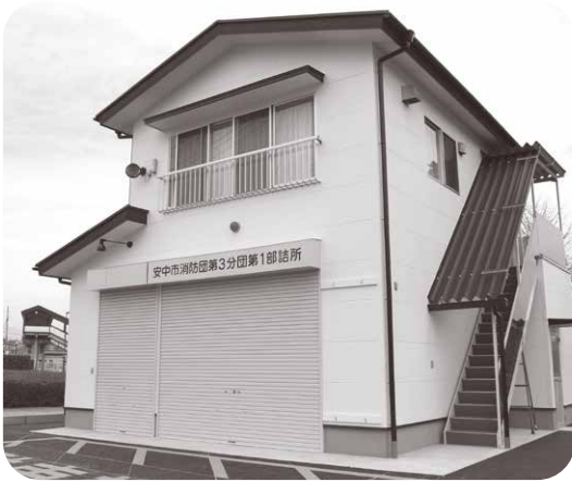
新築された消防団詰所
