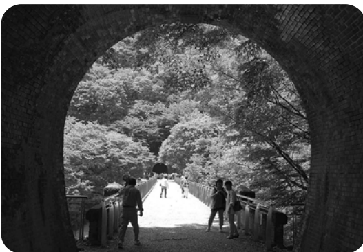
アプトの道 (碓氷第三橋梁)
