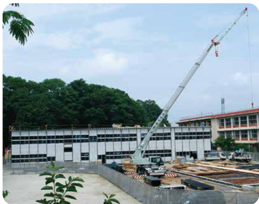
碓東小学校仮設校舎
