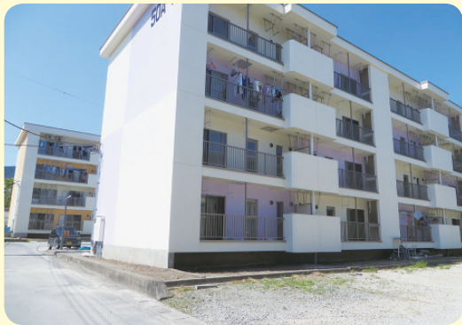
改修された市営秋間団地
