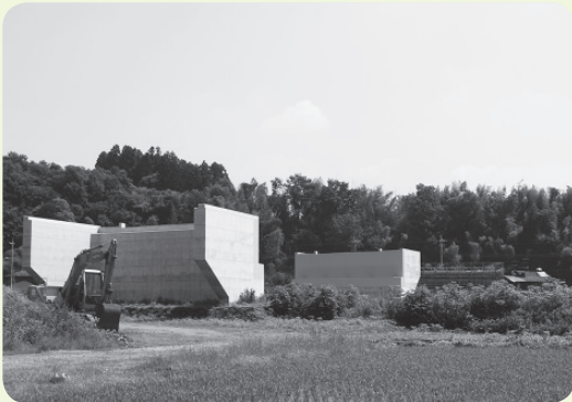
工事が進む西毛広幹道
