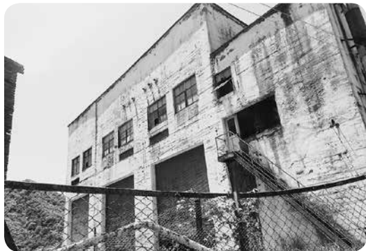
整備が待たれる熊ノ平変電所
