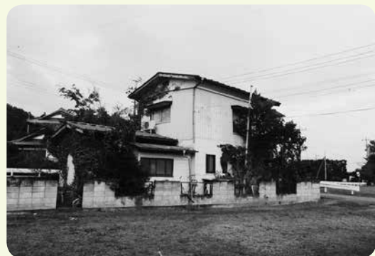
市内の空き家
