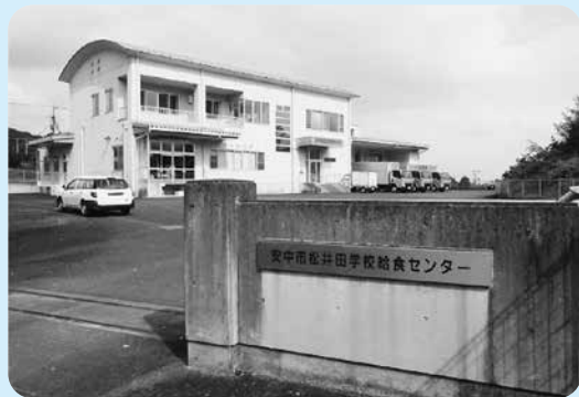
学校給食を提供する、安中市松井田学校給食センター
