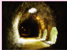
排煙口のある6号トンネル内部
