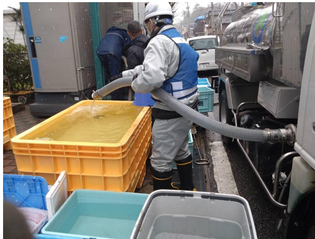
トイレ用仮設水槽へ補水
