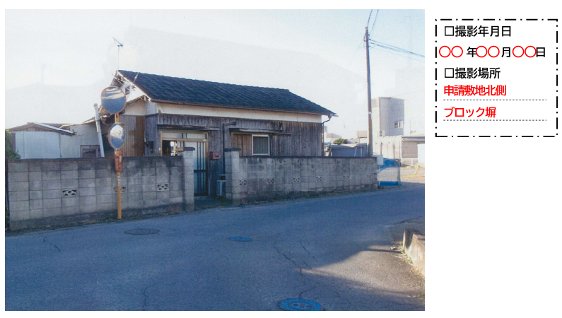
図6 設置状況が確認できる現場写真の例
