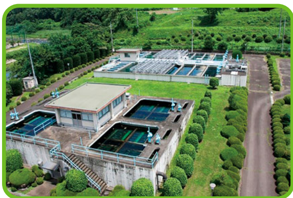
久保井戸浄水場
