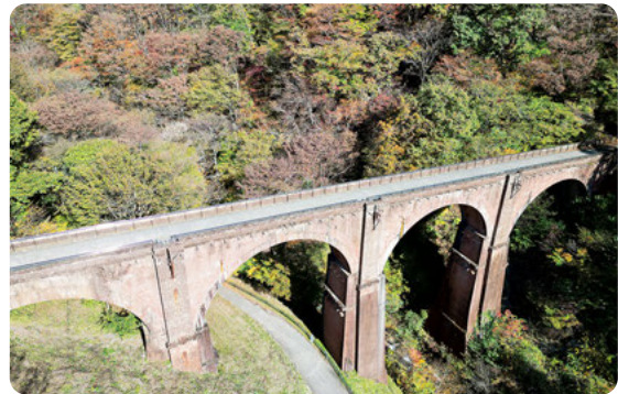
碓氷第三橋梁(通称「めがね橋」)
