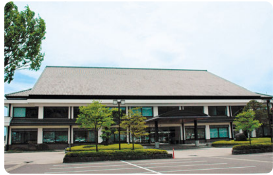
安中市役所 松井田庁舎
