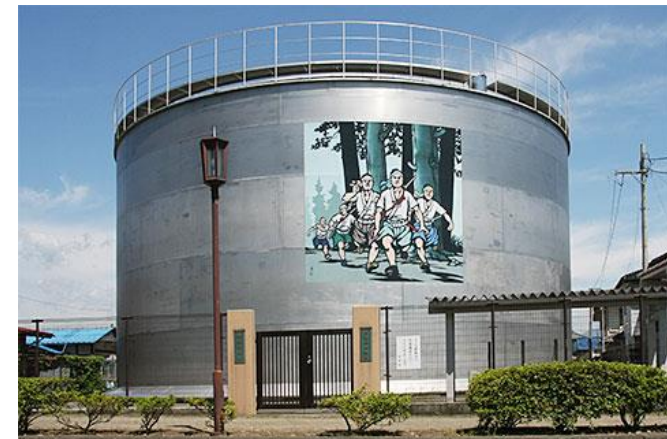
並木副配水池
