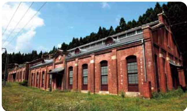
国重要文化財の旧丸山変電所
