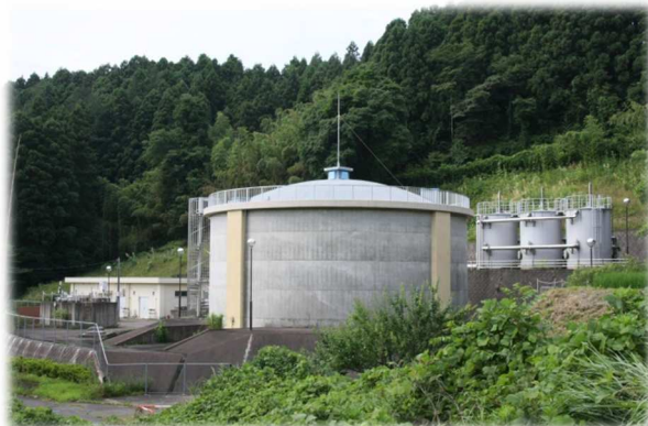
滝ノ入浄水場
