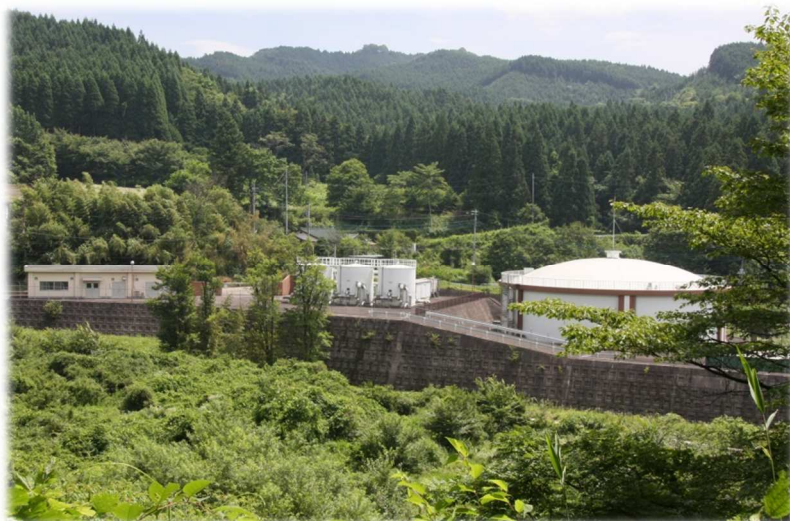
一ノ瀬浄水場
