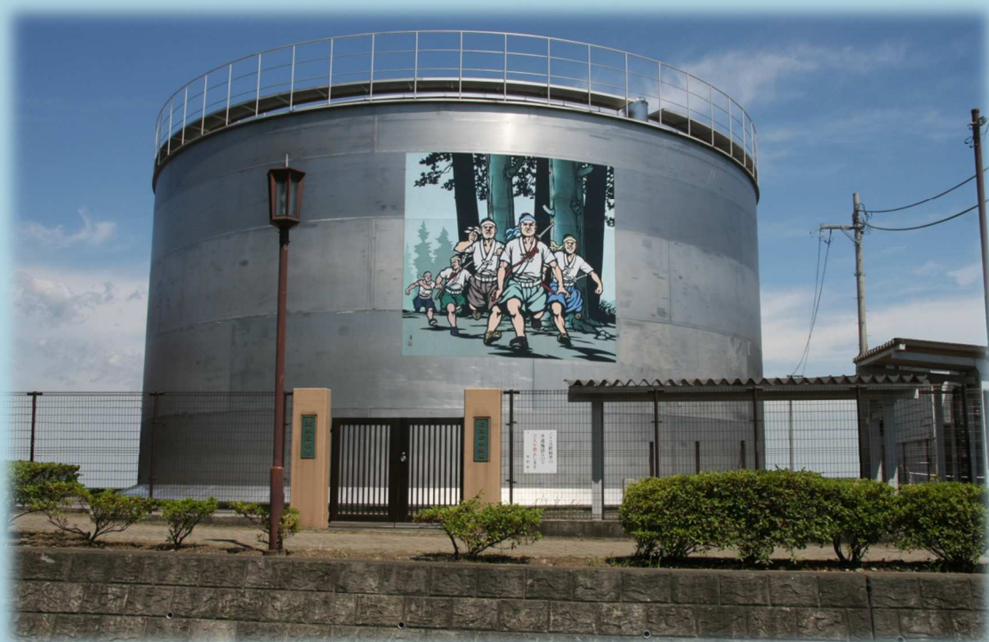
並木副配水池
