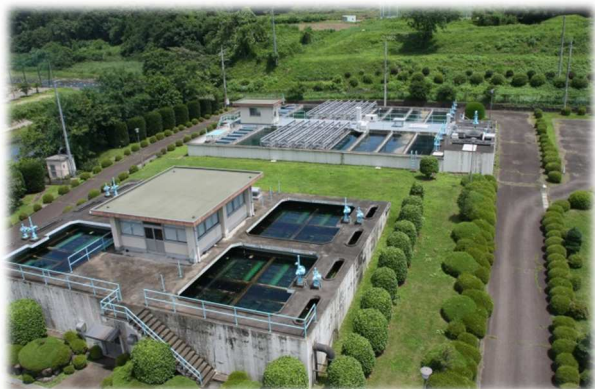
急速ろ過池(手前)と沈殿池(奥)
