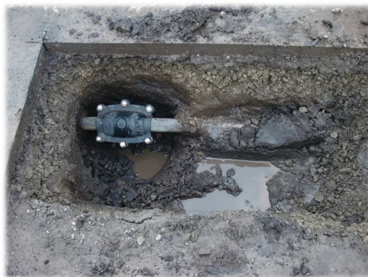
ビニル管 φ50mm の配水管漏水修理
