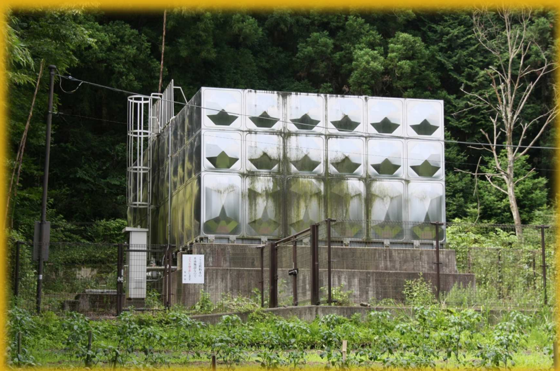
栃久保配水池
