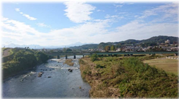
碓東大橋より安中市街を望む
