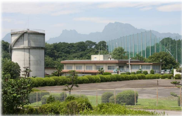
管理棟(右)と高架水槽(左)
