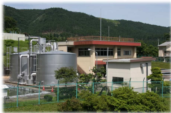
管理棟(右)と急速ろ過機(左)
