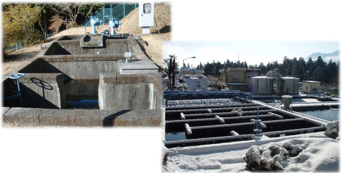
坂本浄水場第一水源(碓氷川)系着水井(左)と沈殿池(右)
