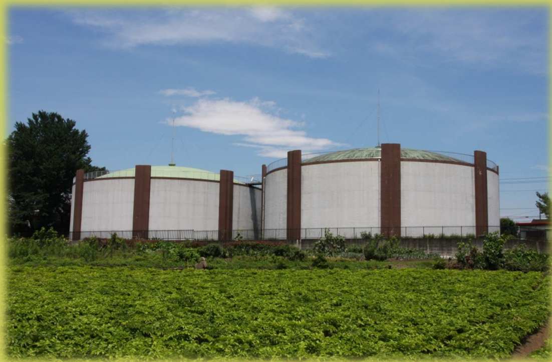
西郷原配水池
