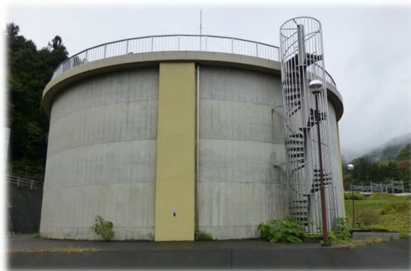
滝ノ入配水池
