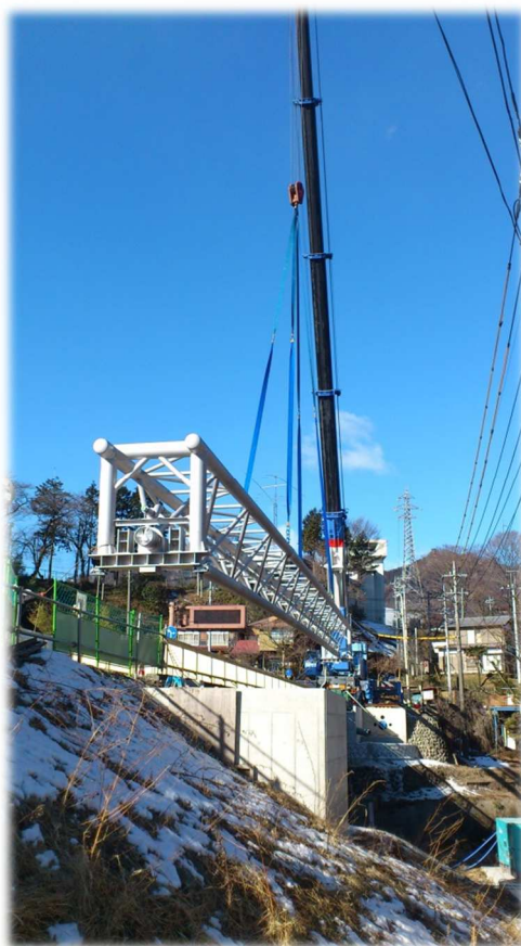
霧積川の水管橋架設状況
