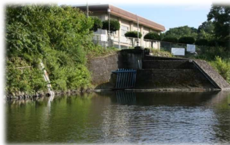
久保井戸浄水場取水施設(人見堰)
