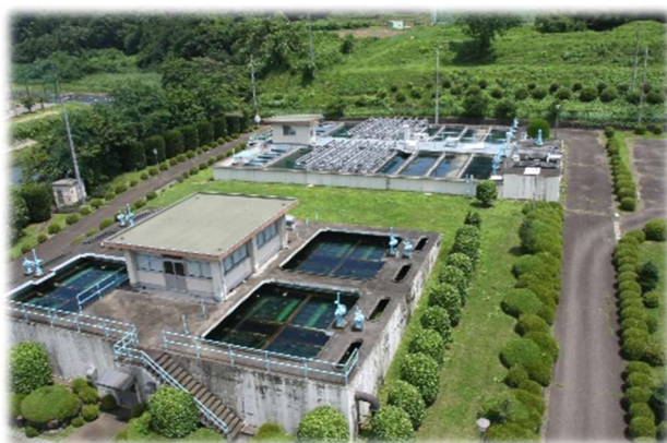
急速ろ過池（手前）と沈殿池（奥）
