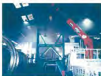
架台取付作業
