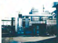
電気伊集産業機設置
