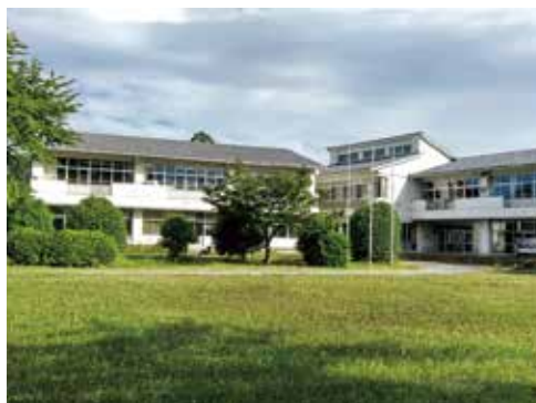
早急な利活用の検討が望まれる 閉校後の校舎施設
