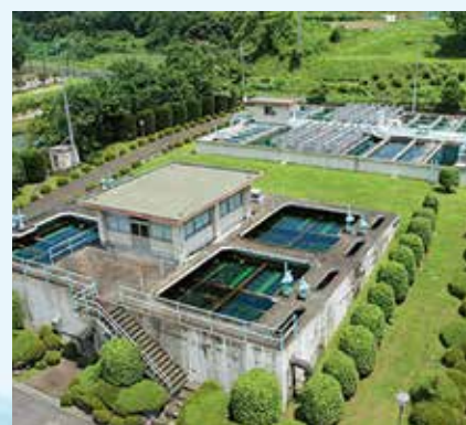
上空からみた久保井戸浄水場
