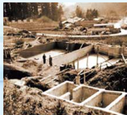
建設中の坂本浄水場
