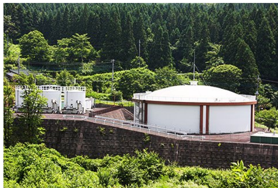
一ノ瀬配水池
