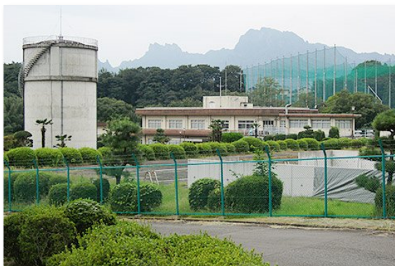
高架水槽（左）と管理棟（右）
