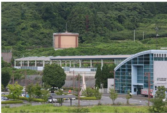
間野田配水池外観
