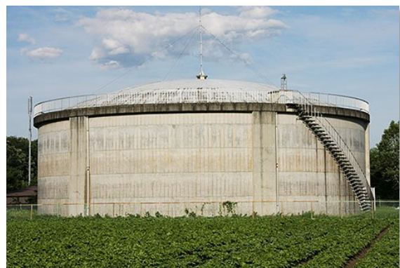
人見配水池外観
