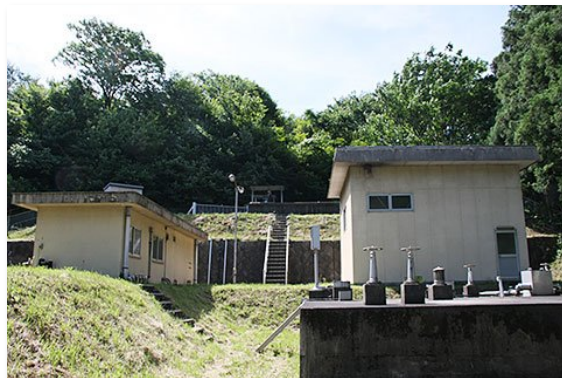
入牧浄水場外観
