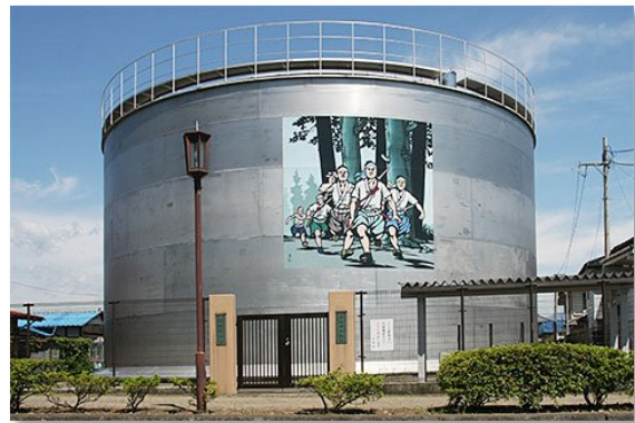
並木副配水池外観
