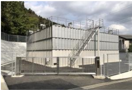
榎木配水池外観
