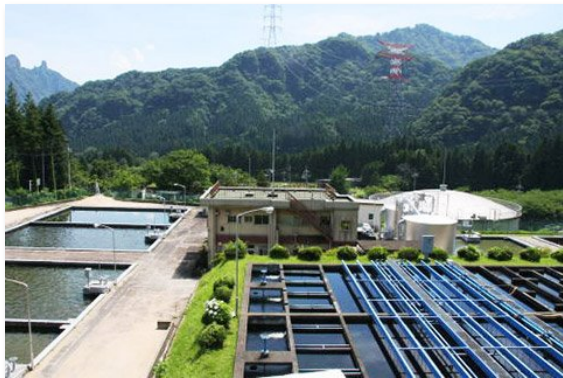
緩速ろ過池（左）と沈殿池（右）
