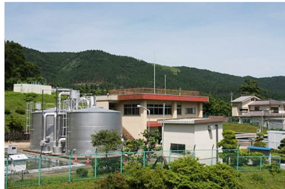
急速ろ過機（左）と管理棟（右）
