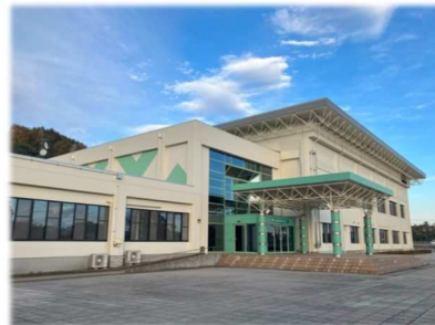
安中市スポーツセンター
