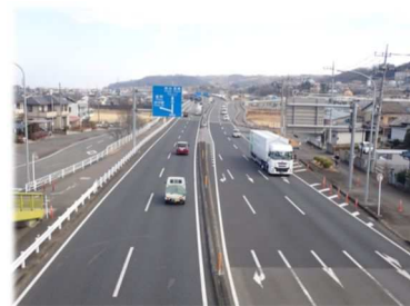
国道18号 (交差点改良区間)
